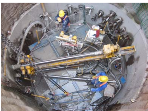
Abb.6: Ventilbohrungen mit einem Lafettenbohrgerät
